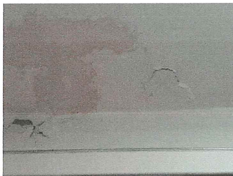
SERVICIOS EDUCATIVOS (VIGAS Y COLUMNAS DE CONCRETO REFORZADO CON LOSA MACIZA)
