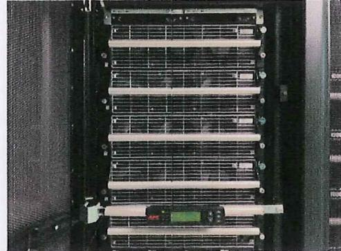
Durante el proceso de extracción e inserción de módulos de batería el sistema UPS Symmetra se mantuvo en operación normal.
